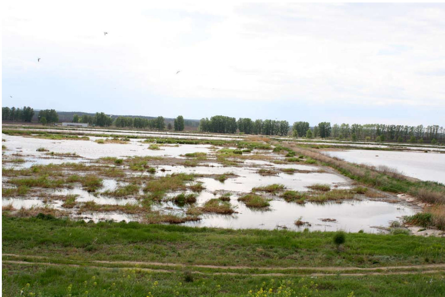
КОТР Поволжский, очистные пруды
