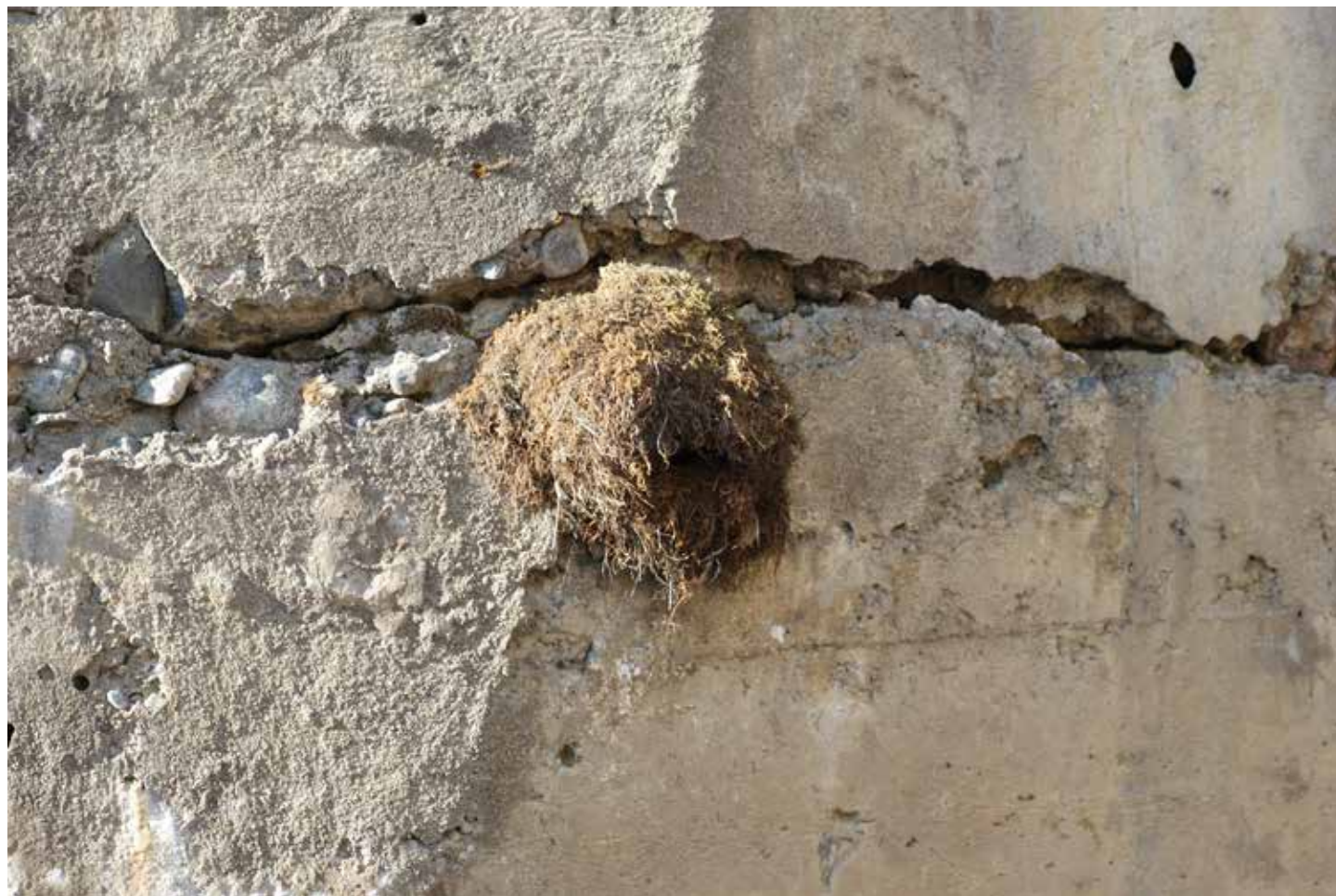
Гнездо оляпки на мосту через р. Лавну. Июнь 2017 г.
