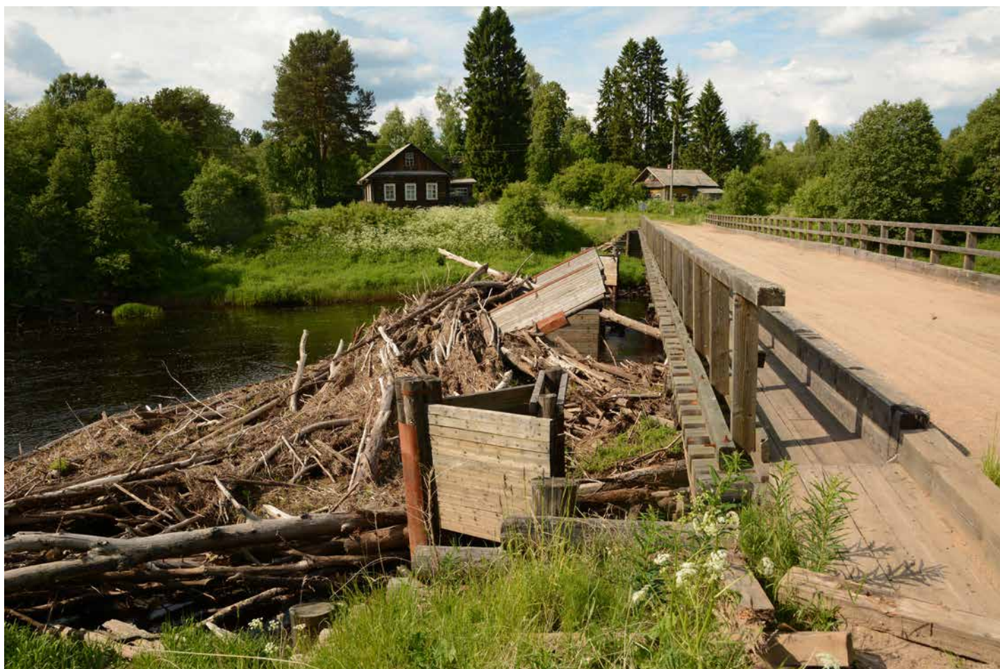
Мост через реку Шола в районе д. Молино
