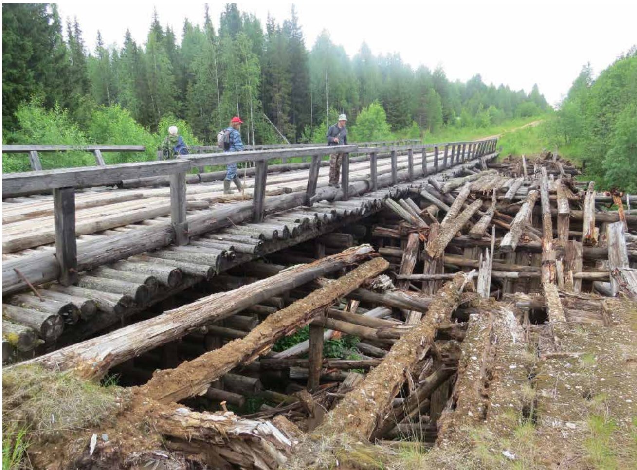
Мост через р. Пиму
