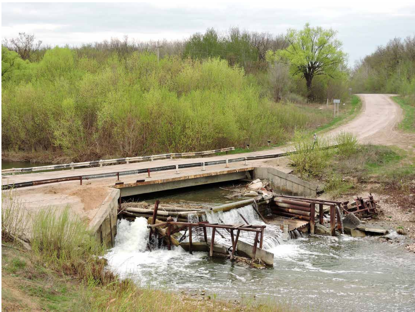
Гидротехническое сооружение из подручного материала. Зато Иргиз не пересыхает летом
