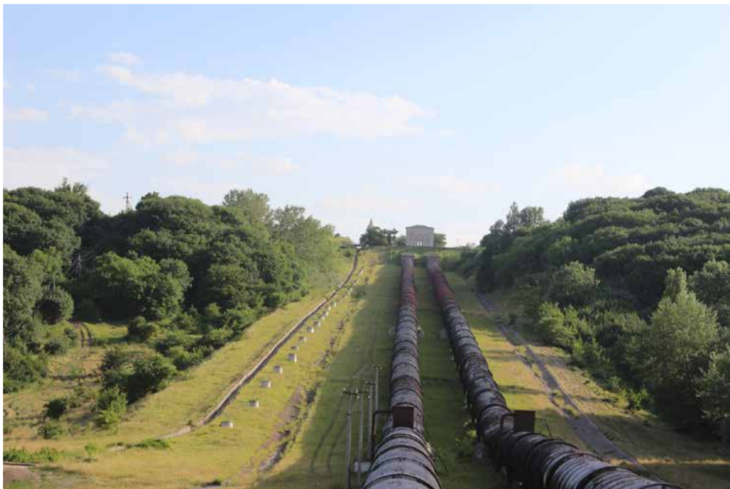
Дюкер Большого Ставропольского канала
